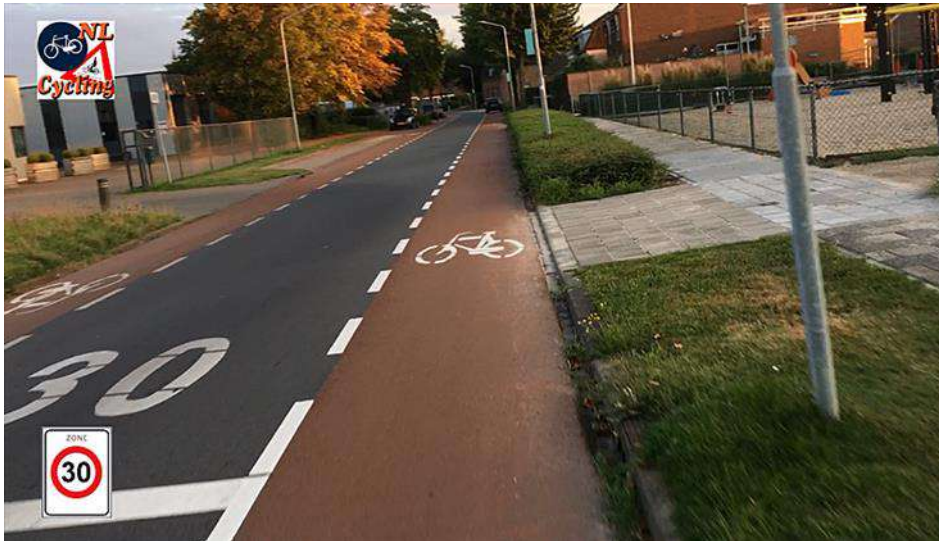
Εικόνα 3. Παράδειγμα οριζόντιας σήμανσης για οδό μειωμένης ταχύτητας
